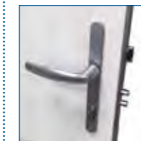
POINT LATÉRAL : SERRURE + 2 PÊNES CYLINDRIQUES
